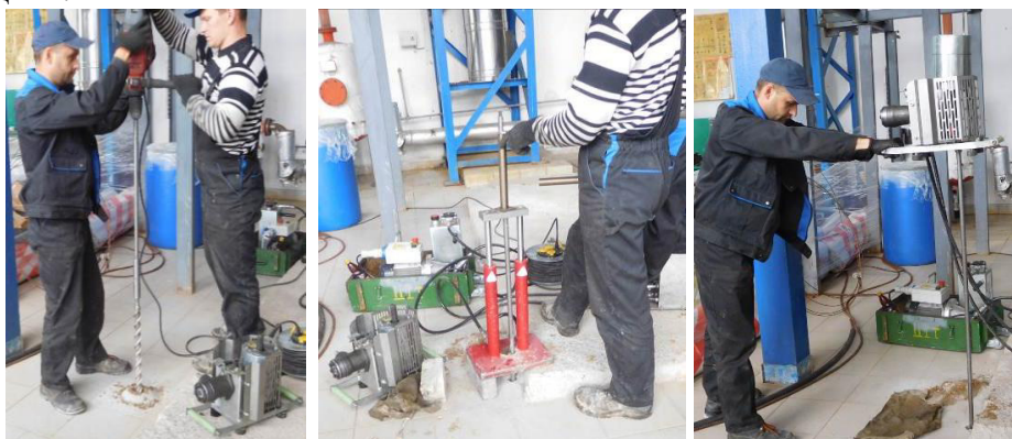
а) б) в) Рис. 2 – Проходка скважины внутри котельной СОО «Конте Спа» через высверленное отверстие в бетонном полу (а), извлечение штанг бура или зонда из скважины (б) и динамическое зондирование ґрунта в скважине (в)
