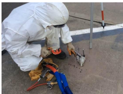
Рис. 3 – Работы по выравниванию плиты рулежной дорожки в аэропорту
